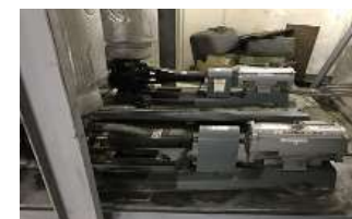
冷温水2次ポンプ
