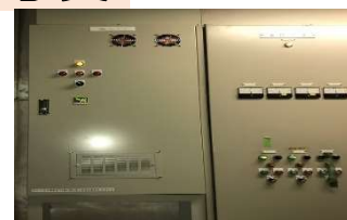
インバータ制御盤
