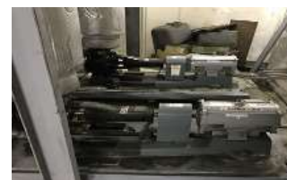
冷温水2次ポンプ
